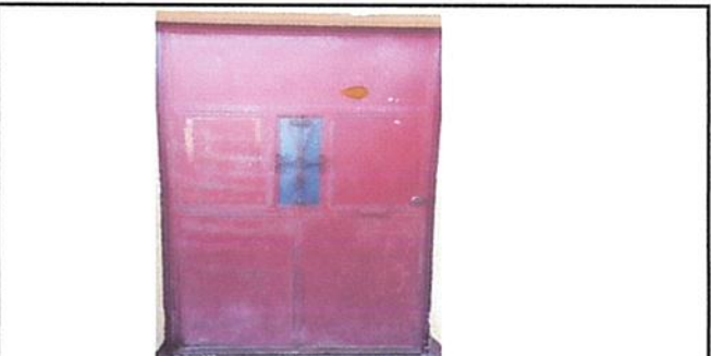
Foto 4: Mantenimiento de pintura a las puertas en módulo 1 y 2, bodega y cocina
